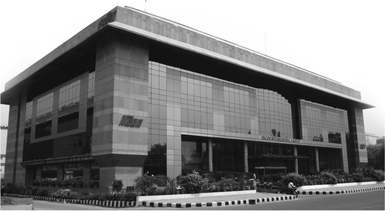
इरकॉन का कार्पोरेट कार्यालय भवन, साकेत, नई दिल्ली
