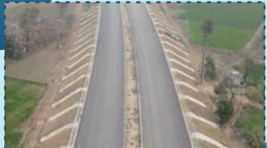
लुधियाना रूपनगर राजमार्ग परियोजनाए Ch 68+100 पर साइड स्लोप प्रोटेक्शन के साथ DBM कार्य
