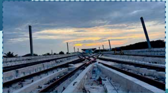
चेन्नई मेट्रो रेल परियोजनाएं ट्रैक सेंटर 12 एम के साथ सिजर क्रॉस ओवर
