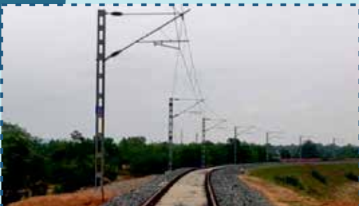
कोरीछापर से धरमजयगढ़ खंड, छत्तीसगढ़ ईस्ट रेल कॉरिडोर में ओएचई कार्य
