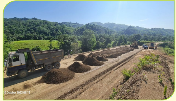
GSB Top Layer Laying @KM 3+400, Myanmar
